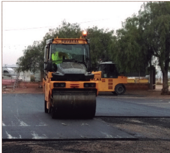
Obras d'adequación de la pista deportiva del San Juan de Ribera.
