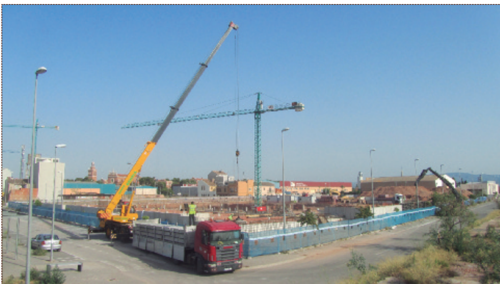
Obres de construcció del nou Hospital Veterinari de la Universitat Cardenal Herrera CEU al campus d'Alfara.
