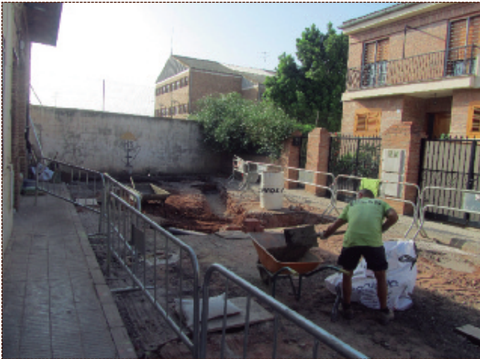
Obres al carreró a la prolongació del carrer Doctor Navarro.
