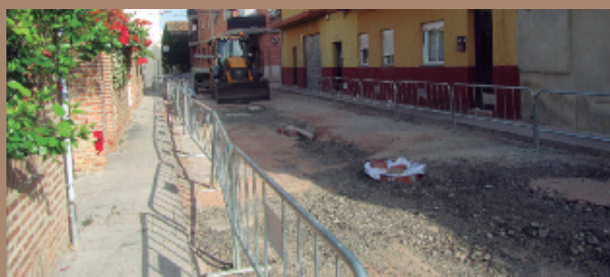
Obres al carrer Prolongació Doctor Navarro.
